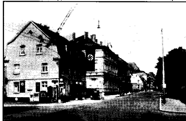
Tankstelle an der Ecke Breite Straße, heute Mettmanner Hof
